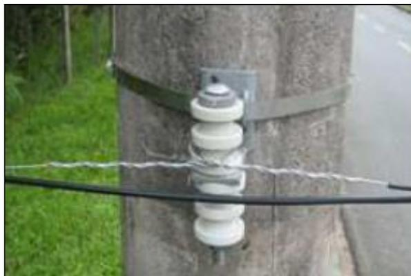
04 – Ao tracionar o cabo (sempre pelo fio de aço galvanizado), seguir os raios máximos de curvatura indicados na Especificação do produto (normalmente o raio mínimo de curvatura não deve ser menor do que 20 vezes o diâmetro do cabo a ser instalado. Uma boa referência é um raio mínimo de 150 mm).
