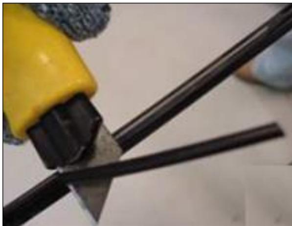
02 – Separar o fio de aço galvanizado da parte do cabo que contém os elementos ópticos, tomando o cuidado de não dobrar ou forçar mecanicamente os mesmos.
